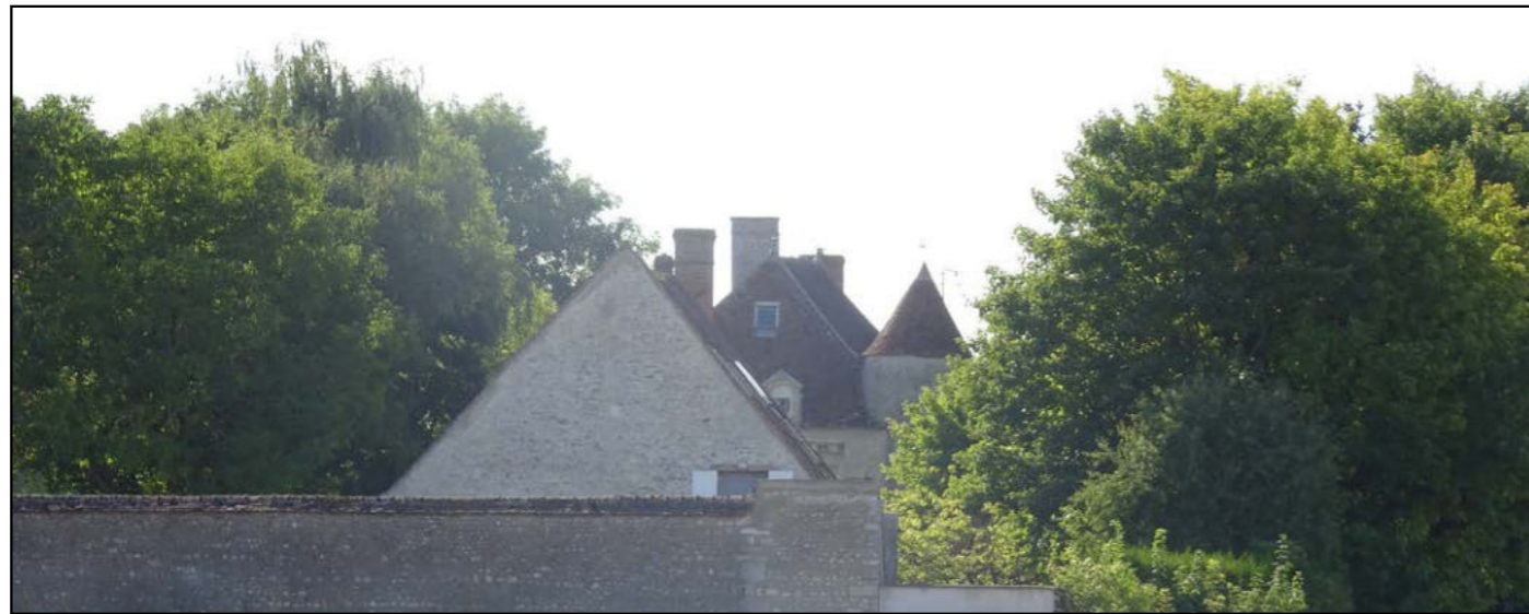
PHOTO 143 : ÉDIFICE PROTÉGÉ (© AGENCE COUASNON)
