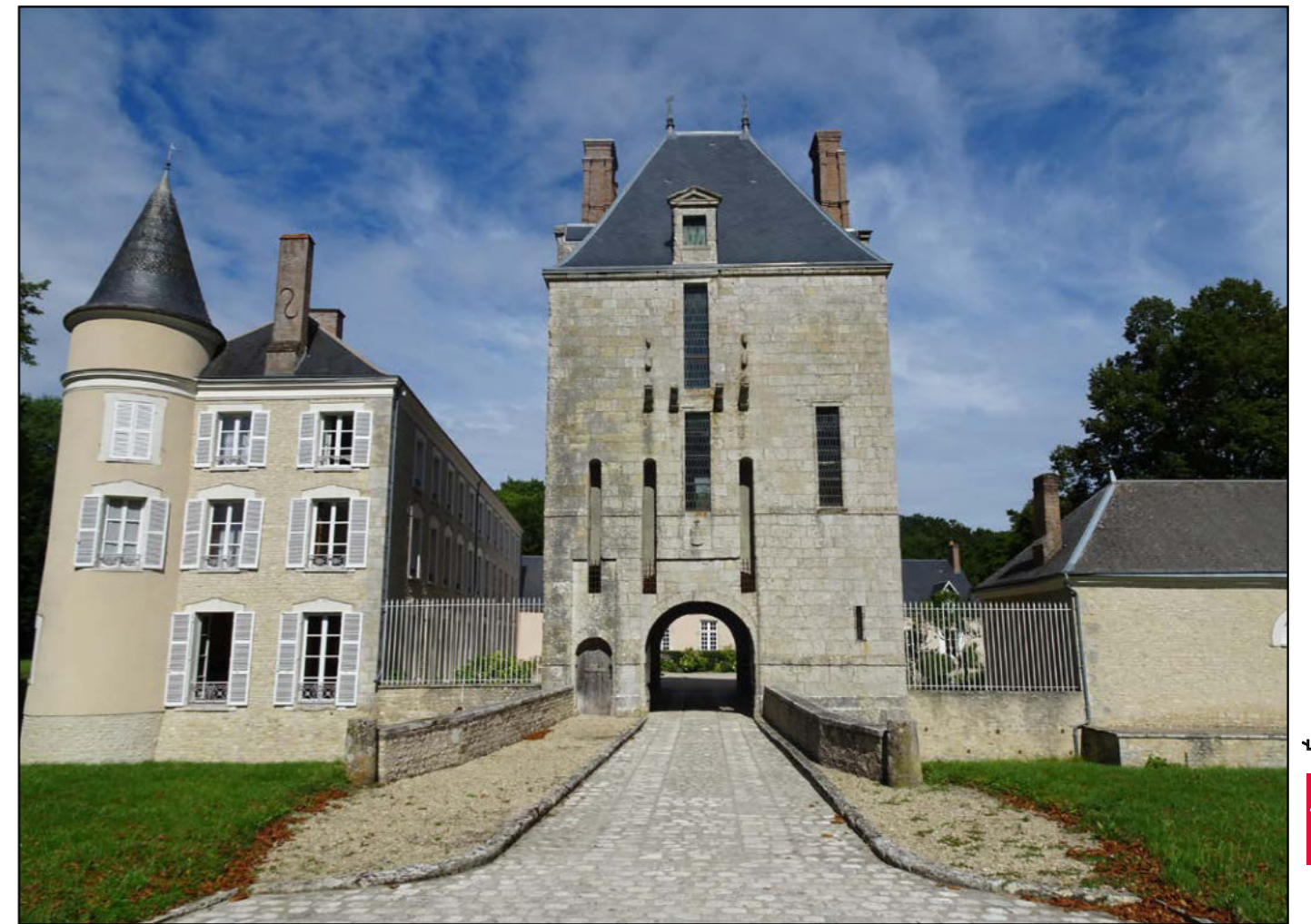
PHOTO 146 : ÉDIFICE PROTÉGÉ (© AGENCE COUASNON)
